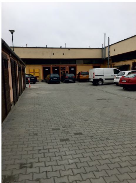
Droga pawilon - po remoncie
