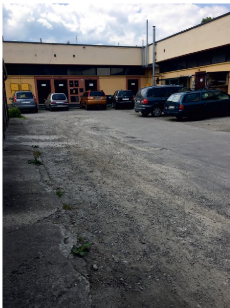
Droga pawilon - przed remontem
