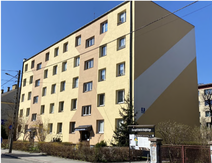
Budynek przy ul. I-go Pułku Strzelców Podhalańskich 8 elewacja po remoncie.
