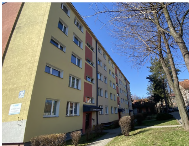
Budynek przy ul. Matejki 32 elewacja po remoncie.
