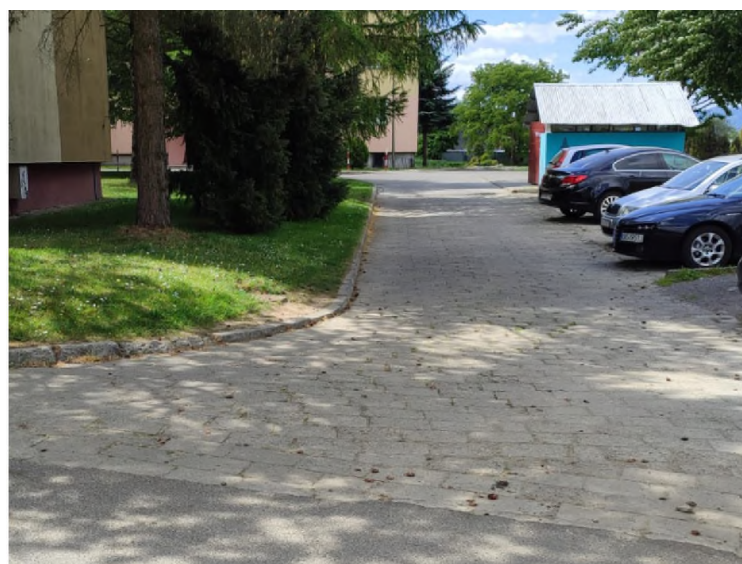
Regeneracja odcinka nawierzchni przy os. Słoneczne.
