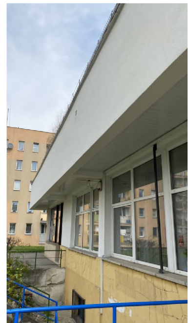
Budynek przy ul. Kr. Jadwigi 31 elewacja po remoncie.
