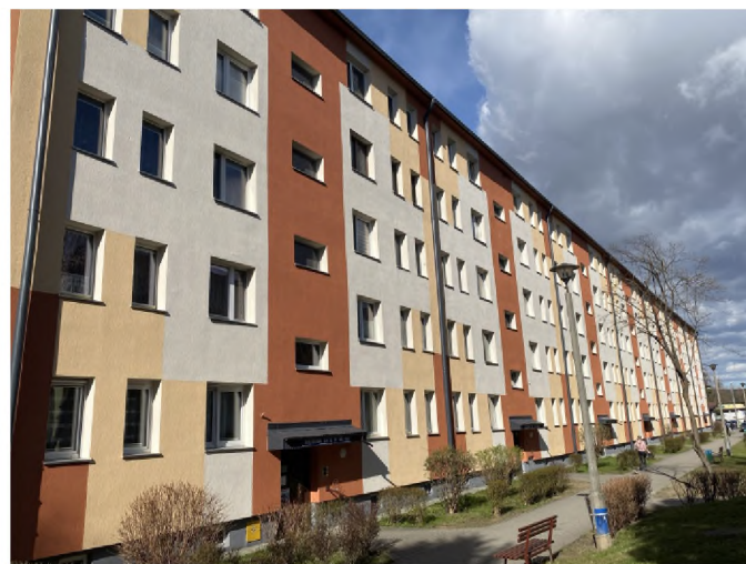
Budynek przy ul. Rejtana 14 elewacja po remoncie.
