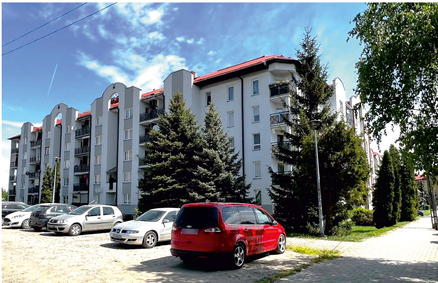
Wyremontowana elewacja przy ul. Traugutta 35
