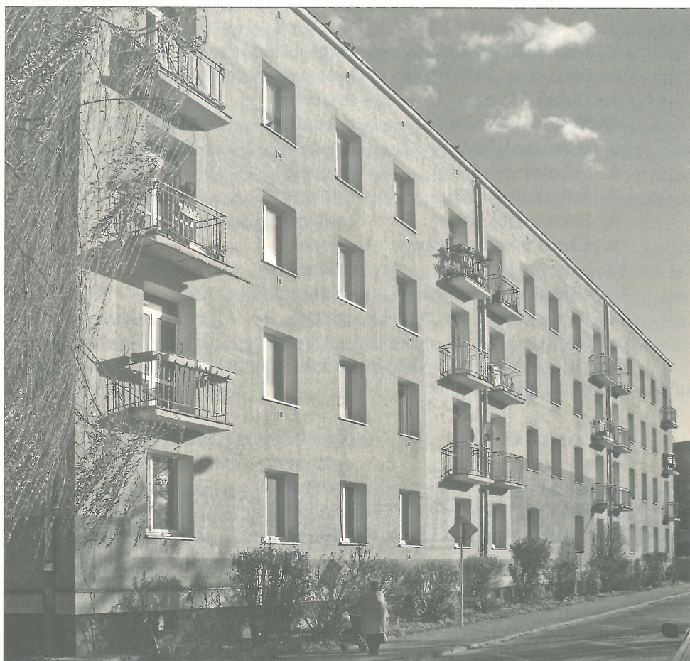
Budynek Grodzkiej Spółdzielni Mieszkaniowej przy ul. Żółkiewskiego 25
