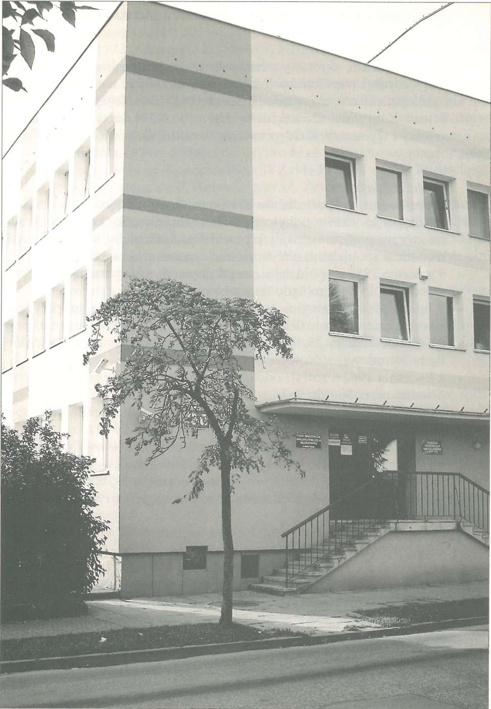
Siedziba Grodzkiej Spółdzielni Mieszkaniowej przy ul. Grodzkiej 30
