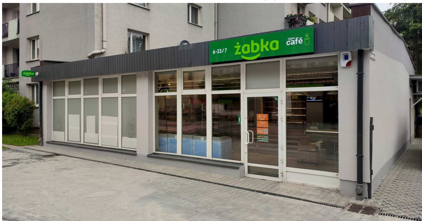
Nowo powstający sklep na ul. Długosza 35
