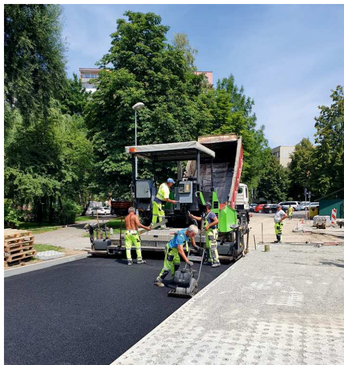
Remont nawierzchni przy ul. Armii Krajowej
