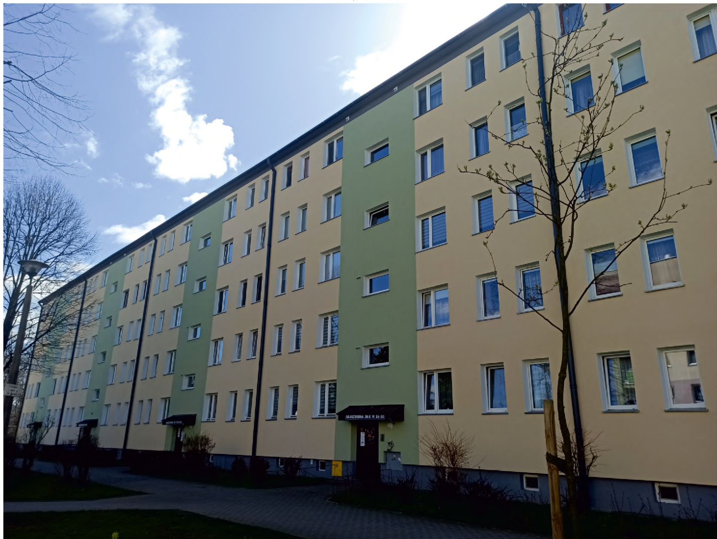
Wyremontowana elewacja budynku Klasztorna 36.
