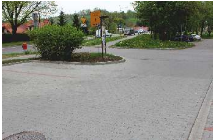
Nowo wyremontowany parking przy ul. Barskiej
