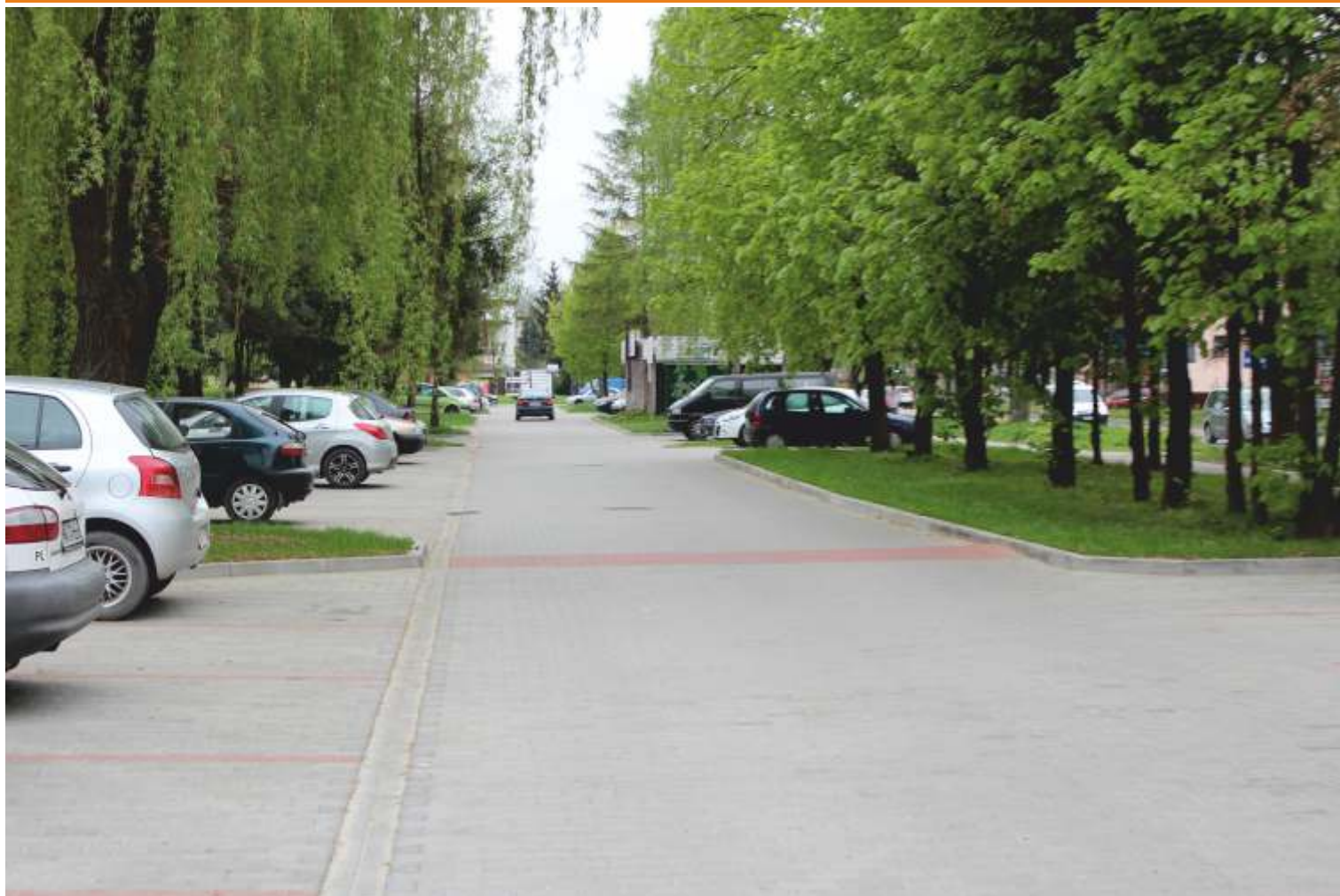
Nowo wyremontowany parking przy ul. Barskiej
