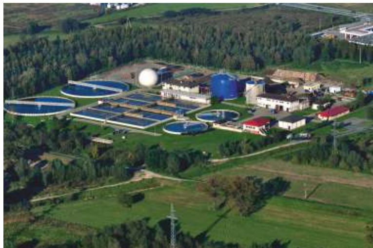
Oczyszczalnia ścieków w Nowym Sączu
