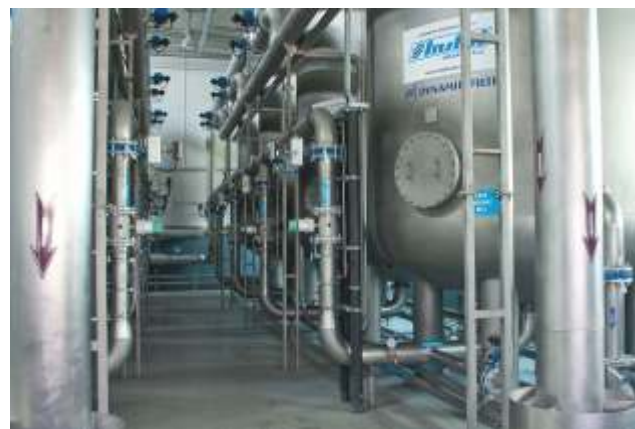
Stacja Uzdatniania Wody w Starym Sączu
