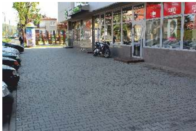
Nowo wyremontowany chodnik przy ul. Kochanowskiego
