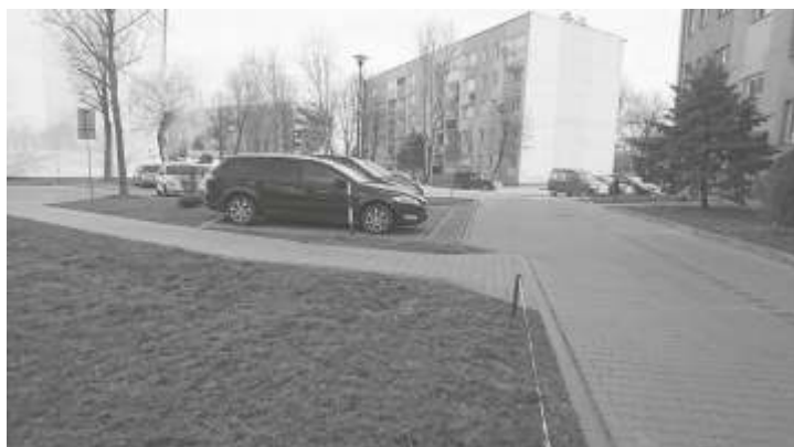
Wykonanie drogi pieszo-jezdnej wraz z miejscami postojowymi os. Słoneczne 2
