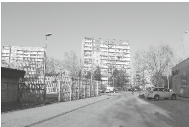
Nowo wyremontowany parking przy Armii Krajowej
