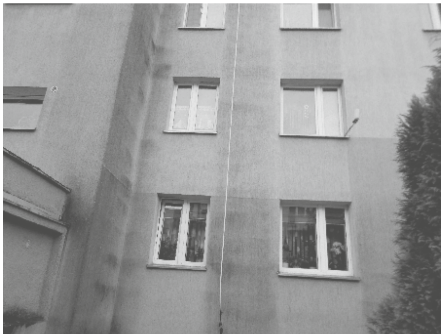
Ściana zewnętrzna os. Słoneczne 8 przed remontem
