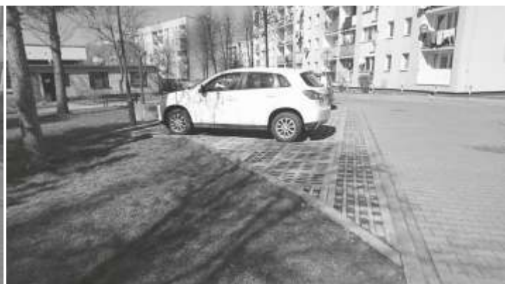
Wykonanie miejsc postojowych przy bud. os. Słoneczne 4
