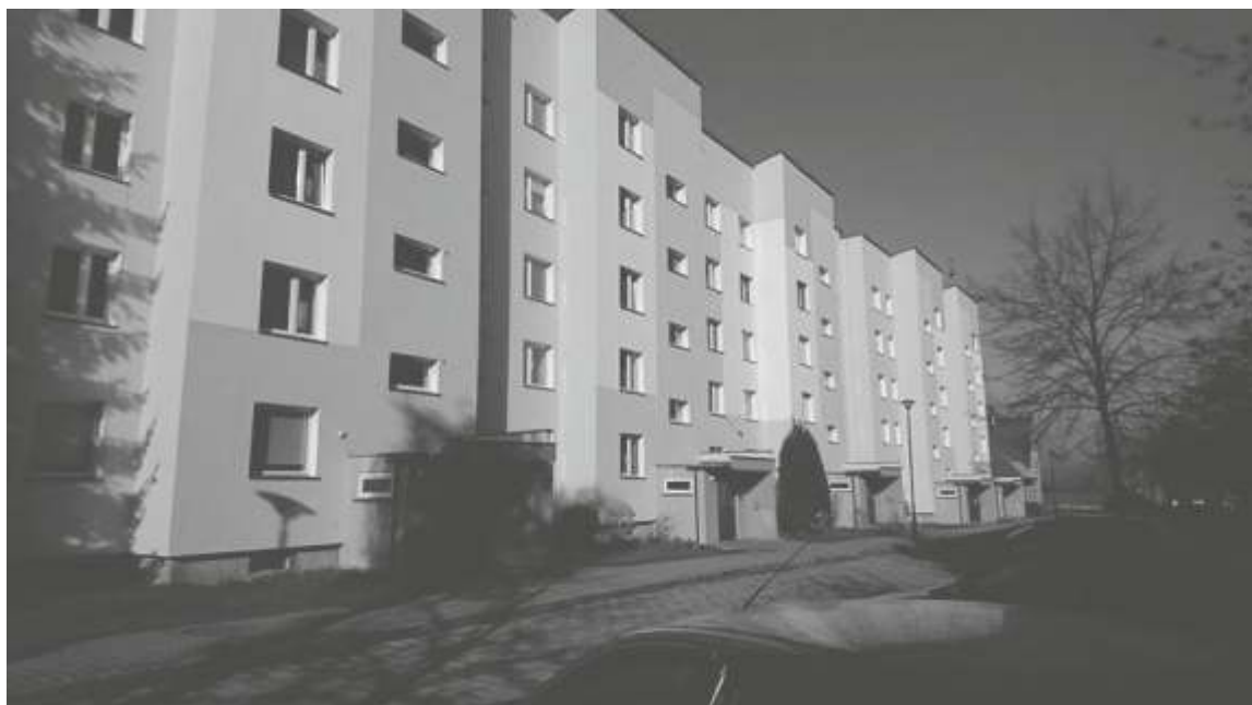
Ściana zewnętrzna os. Słoneczne 8 po remoncie
