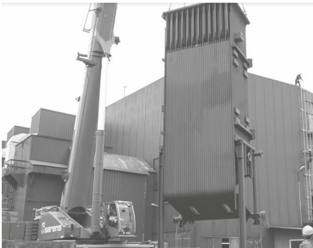
Montaż nowego kotła w kotłowni na osiedlu Millenium
