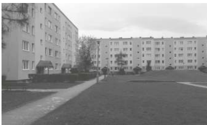
Nowo wyremontowana elewacja przy ul. Partyzantów
