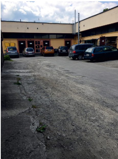
Droga pawilon - przed remontem
