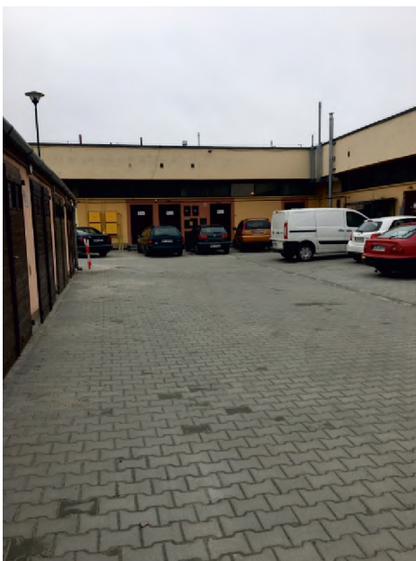
Droga pawilon - po remoncie
