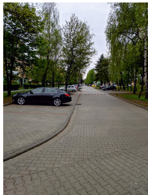
Nowo wyremontowany parking przy ul. Barskiej
